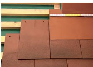
**1** Préparer la pièce de raccordement à la longueur nécessaire (8 cm sous la tuile amont et 20 cm minimum sur le retour en rive de tête).
