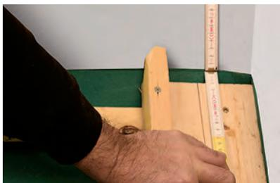
2 Mesurer préalablement la hauteur du relevé en tête en partant de la fonçure jusqu'au repère tracé lors de la mise en œuvre de la rive de tête adossée (cf. p 11). Mesurer la longueur nécessaire de WAKAFLEX® en tenant compte de la hauteur du relevé en tête et du recouvrement du couloir déjà mis en œuvre (5 cm ou 10 cm selon la pente - cf. p 5).
