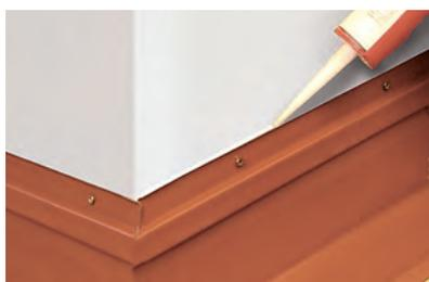
**10** Poser et fixer la bande porte solin, compléter l'étanchéité avec un joint.
