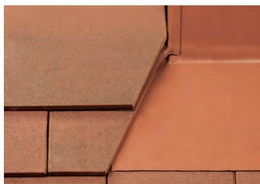
**5** Découper les tuiles en recouvrement suivant le tracé de la première.
