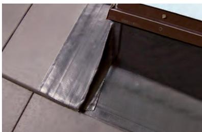
**6** Raccorder le noquet sur la pièce d'angle mis en place au point n°2 afin d'assurer l'étanchéité entre ces deux pièces.
