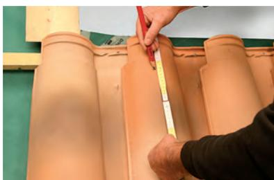
**2** Vérifier que le recouvrement sur la tuile est bien de 10 cm minimum dans la zone d'écoulement des eaux.
