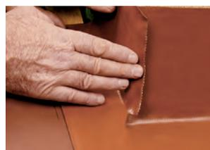
**3** Préparer deux noquets (cf. p 10) suivant la coupe de la tuile et l'angle de raccordement du mur en ajoutant 2 cm afin d'assurer un recouvrement en retour d'angle.
