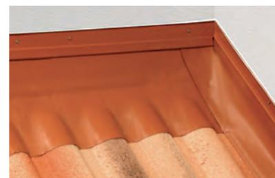
**6** Poser et fixer la bande porte-solin. Compléter l'étanchéité avec un joint.
