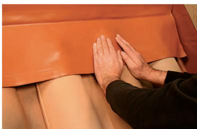
**5** Maroufler progressivement le WAKAFLEX® en partant du point le plus haut vers la zone d'écoulement. La bande de butyle doit adhérer sur toute la longueur avec les tuiles (y compris en zone d'écoulement grâce à la capacité d'étirabilité du WAKAFLEX®).
