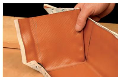
5 Réaliser un mouchoir en recouvrement sur la partie en contact avec le mur.
