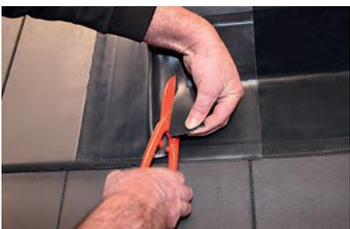
**5** Découper la partie en recouvrement parallèlement au noquet.
