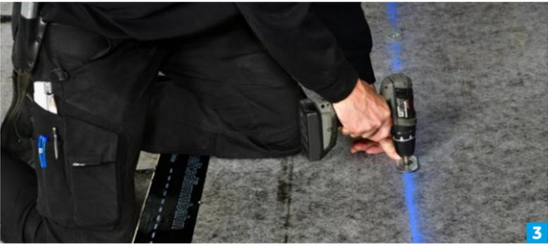
3. Bei nicht ausreichender Nahtbefestigung sind die Bahnen in der Mitte zusätzlich gemäß Windsognachweis zu befestigen
