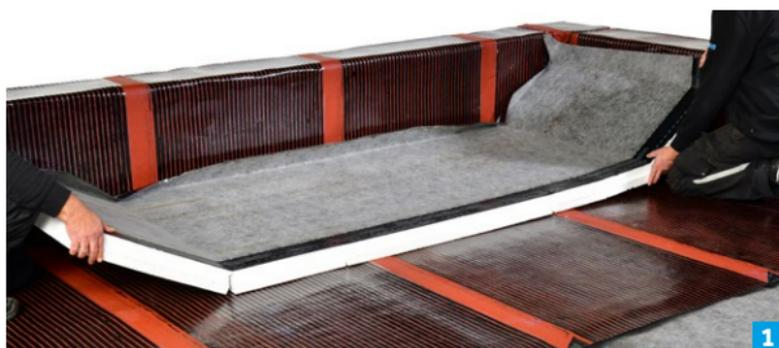
1. Sicherheitsdämmbahn passend auf der Dachfläche ausrichten. Einjustieren nach Einlegen in die aktivierten Thermstreifen ist nicht mehr möglich
