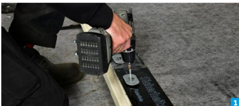
1. Icopal Sicherheitsdämmbahnen in der Naht gemäß Windsognachweis mit zugelassenen Befestigern fixieren
