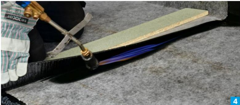
Durch abziehen und andrücken des SK-Streifens der Längsnaht wird eine Flammabschottung erzeugt (Foto 5).
