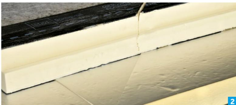
2. Getrennte Sicherheitsdämmbahn passend zum Gratlinienverlauf auf der Gefälledämmung platzieren und ggfs. je nach Lage-sicherung verkleben oder verschrauben. Bei Auflast wird zuerst die restliche Dachfläche fertig gestellt.
