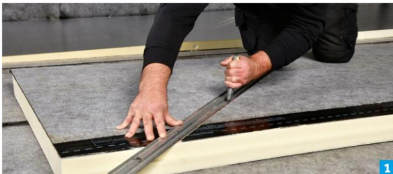
1. Icopal Sicherheitsdämmbahn nach Aufmaß passend an den Gratlinienverlauf oberseitig einschneiden und Element vollständig durchtrennen. (Tipp: Bei Entfernung eines schmalen Streifens der Kaschierlage kann der Dämmstoff sauber durchtrennt werden, ohne das Schneidwerkzeug mit Bitumen zu verunreinigen)
