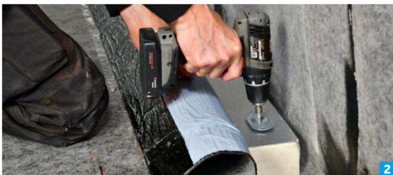
2. Bei Icopal PIR-Sicherheitsdämmbahnen kann die Nahtüberlappung der Längsnaht zurück geklappt werden, wodurch die PIR-Dämmplatten fachgerecht auf beiden Seiten befestigt werden können.
