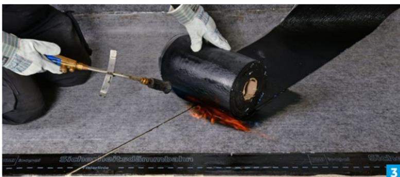
3. Die durchtrennte Kaschierlage wird mittels eines 20 – 30 cm breiten Zulagestreifens (z. B. Icopal Anschlussbahn unbestreut oder bestreut) fachgerecht verschweißt.
