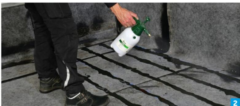
2. Bei ungünstigen Witterungsbedingungen oder PIR-Sicherheitsdämmbahnen Streifen zusätzlich mit Sprühnebel befeuchten
