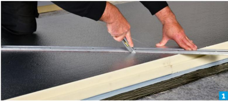
1. Icopal Sicherheitsdämmbahn nach Aufmaß passend an den Kehllinienverlauf rückseitig einschneiden. Die Kaschierlage dabei nicht durchtrennen.
