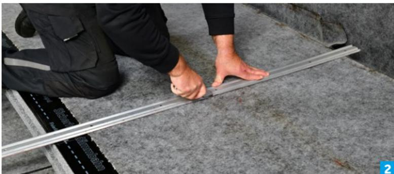
Das Reststück der 1. Reihe bildet den Anfang der 2. Reihe, wodurch ein Reihenversatz erzeugt wird und Kreuzstöße der Nähte vermieden werden (Foto 3). Icopal Sicherheitsdämmbahnen sind so nahezu frei von Verschnitt zu verarbeiten.
