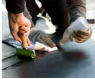
Beim Anschluss des Wolfin IB Zuschnittsstreifens an die Flächenbahn Wolfin PBS mittels Quellschweißmittel, wird unter leichtem Reiben mit einem vulkanisierten Flachpinsel vollflächig und satt Witec Quellschweißmittel (THF) zwischen die Bahnen eingebracht. Unmittelbar danach muss das überschüssige Quellschweißmittel mit einer Silicon-Andrückrolle aus der Naht herausgerollt werden.
