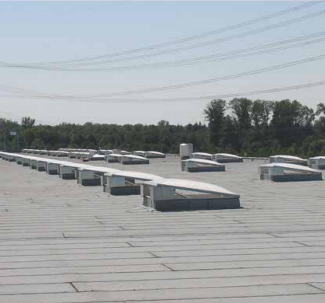
Lichtkuppel-Aufsetzkranz einbauen und befestigen. Anschlussflächen des Lichtkuppel-Aufsetzkranzes mit einem Bitumen-voranstrich vorstreichen.
