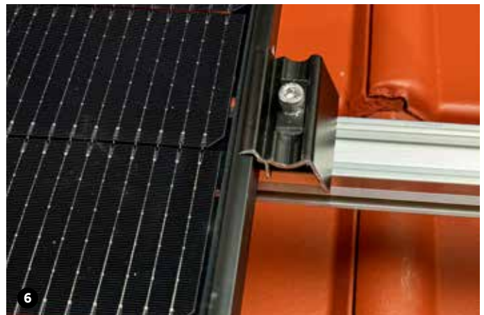
PV-Modul auf die Montageschiene auflegen und Endklammern anziehen. (16 Nm)
