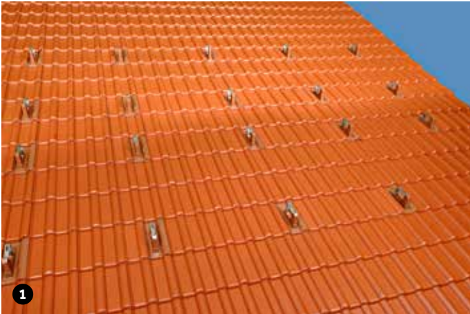
Die Modulstützen und der Modulstützenbügel nach Verlegeanleitung ins Dach einbauen
