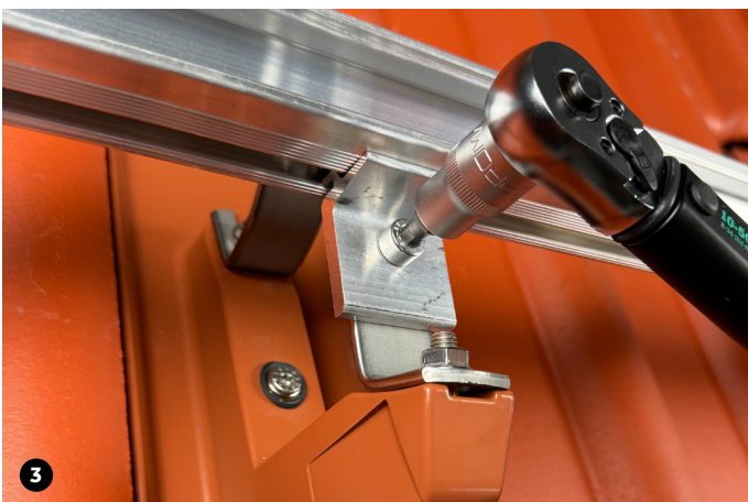
Single Rail auflegen, in den Climber einhängen, seitlich ausrichten und M8 Schraube mit 16 Nm anziehen. Die Verbindung der Montageschienen untereinander erfolgt mit dem mitgelieferten Schienenverbinder Set. Die Schienen werden im Verbinder stumpf gestoßen.
