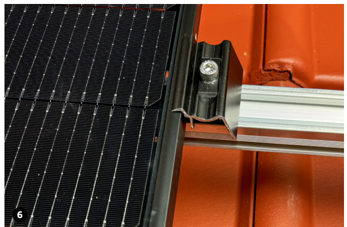
PV-Modul auf die Montageschiene auflegen und Endklammern anziehen. (16 Nm)
