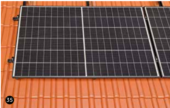
Fertig verlegtes Modulfeld im Kreuzschienenverbund.
