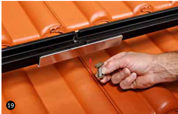
19 Montageschienen mit Schienenverbinder verlängern. Montageschiene auf Stoß verlegen und mit Hilfe des Schienenverbinders und den Hammerkopfschrauben und Sperrzahnmuttern verbinden. Schienenstoß darf sich nicht im Bereich des Modulstützenbügels befinden. Der Verbinder ist mittig über dem Stoß zu montieren. Anzugsdrehmoment 35 Nm.
