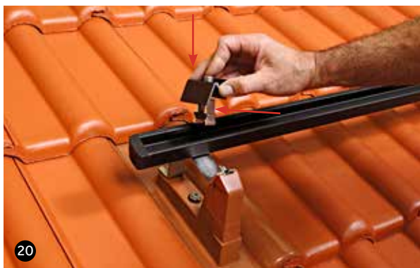
20 Die Universal-End-Modulklemme mit der unteren Klemme in die Modulschiene drücken.
