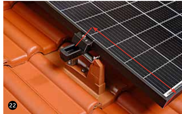
22 Modul auflegen und jeweils am Ende einer Reihe an die Universal-End-Modulklemme anlegen und fixieren. Das Modul nach dem zulässigen Klemmbereich der Module (siehe Punkt 5.8) ausrichten. Anzugsdrehmoment der Zylinderkopfschraube 14 Nm.
