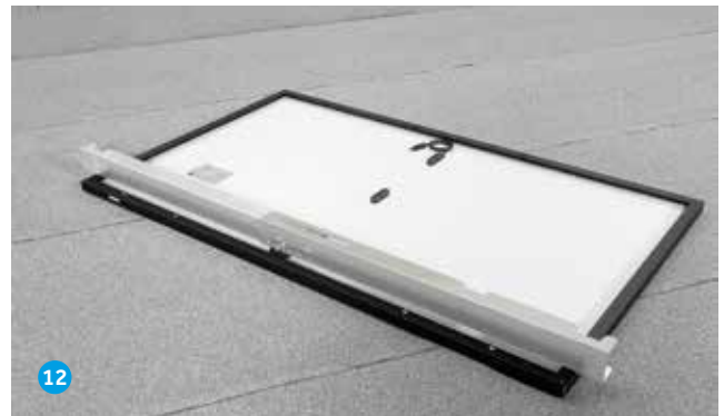
Montageschablone ausrichten.
