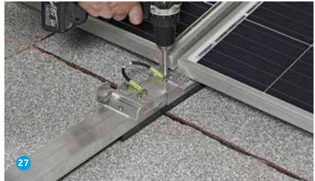
Variante Potentialkabel PV easywave XXL (Länge Kabel 160 mm)
