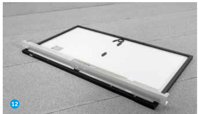
Montageschablone ausrichten.
