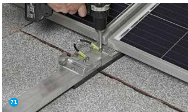
Variante Potentialkabel PV easywave XXL (Länge Kabel 160 mm)
