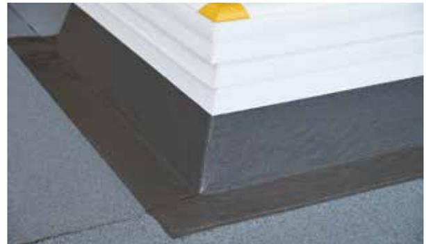
4. Abzudichtenden Bereich satt mit einer Deckschicht von mind.  $1,0 \text{ kg/m}^2$  abdecken
