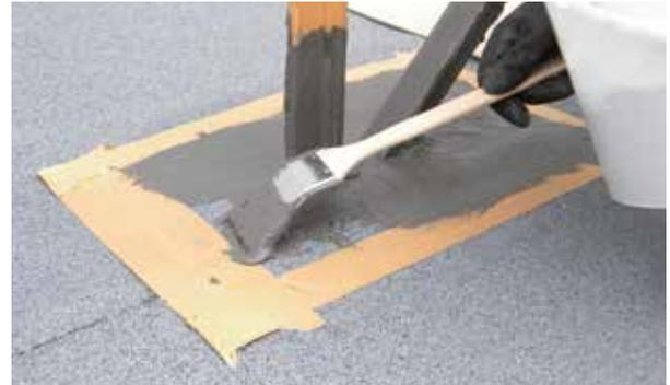
2. Profi-Dicht Faserfix wird mit dem Pinsel aufgetragen und geglättet. Der Anschluss der Detailabdichtung muss mind. 10 cm in die Fläche geführt werden. Die Anschlusshöhen sollen nach Regelwerk hergestellt werden. Abweichungen hiervon sind Sonderlösungen und mit dem Bauherren abzustimmen
