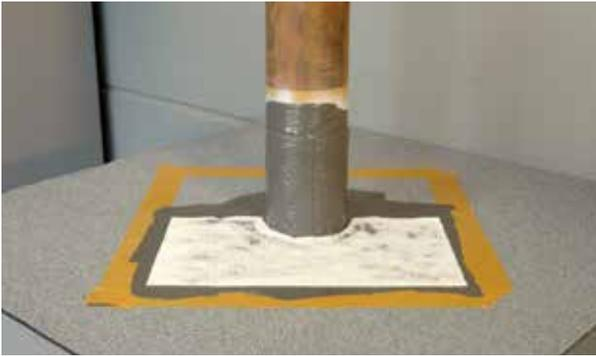
5. Die verarbeitungsfertige Profi-Dicht Mischung, mind. 2,0 kg/m<sup>2</sup>, mit einer Fellrolle satt auftragen und gleichmäßig verteilen
