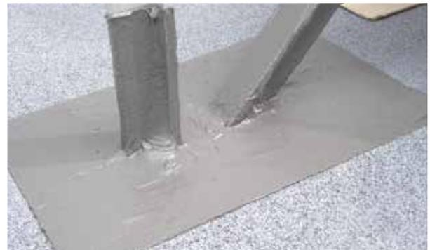
3. Das Klebeband muss entfernt werden bevor Profi-Dicht Faserfix ausgehärtet ist. Danach ist die Abdichtung je nach Umgebungstemperatur nach ca. 30 Minuten regenfest
