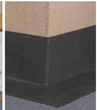
7. Abdichtenden Bereich satt mit einer Deckschicht von mind. 1,0 kg/m<sup>2</sup> abdecken
