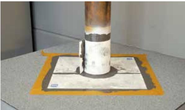
7. Anschließend Profi-Dicht Mischung an der Rohrwandung auftragen und den Zuschnitt Profi-Dicht Vlies anlegen
