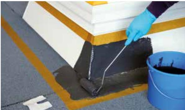
2. Die verarbeitungsfertige Profi-Dicht Mischung, mind.  $2,0 \text{ kg/m}^2$ , mit einer Fellrolle satt auftragen und gleichmäßig verteilen
