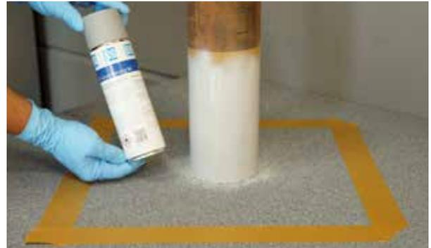
3. Rohre aus Metall mit Profi-Dicht Grundierung M besprühen (siehe Untergrundtabelle ab S. 34)
