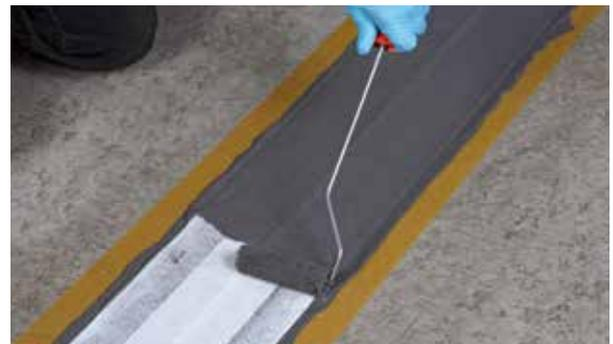
8. Fläche mit einer weiteren Deckschicht, mind. 1,0 kg/m<sup>2</sup> abdecken
