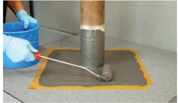
8. Abdichtenden Bereich satt mit einer Deckschicht von mind. 1,0 kg/m<sup>2</sup> abdecken
