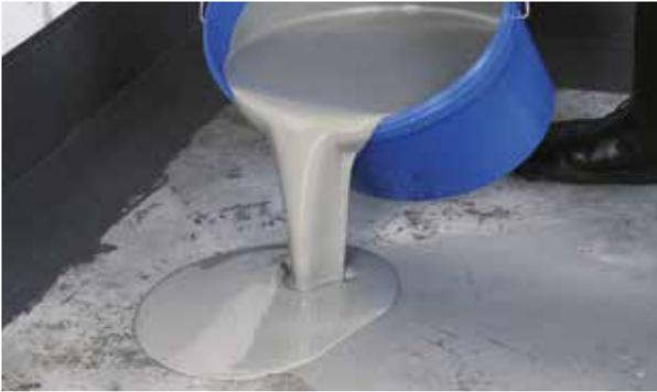
4. Profi-Dicht Fläche satt vorlegen und gleichmäßig verteilen.
