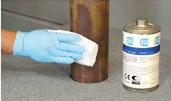
1. Oberfläche mit Profi-Dicht Reiniger abreiben. Rohre aus Kunststoff vorher mit Schleifpapier anrauen. Abluftzeit ca. 20 Min. (siehe Untergrundvorbehandlung ab S. 32)
