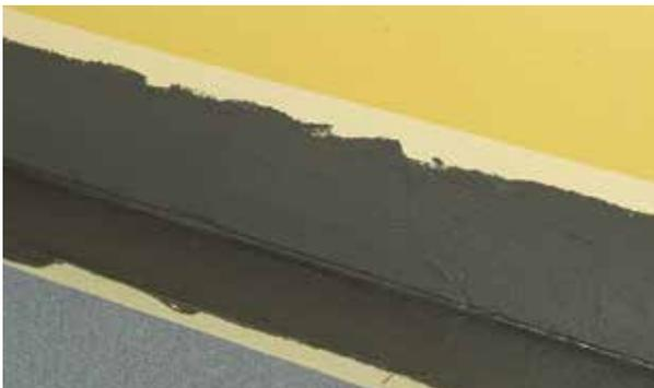
3. Die verarbeitungsfertige Profi-Dicht Mischung, mind.  $2,0 \text{ kg/m}^2$ , mit einer Fellrolle satt auftragen und gleichmäßig verteilen
