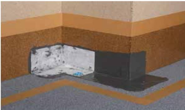
3. Die verarbeitungsfertige Profi-Dicht Mischung, mind. 2,0 kg/m<sup>2</sup>, mit einer Fellrolle satt auftragen und gleichmäßig verteilen
