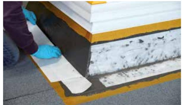
3. Zugeschnittenes Profi-Dicht Vlies einlegen, den Eckbereich so einschneiden, dass es sich blasenfrei anschmiegt
