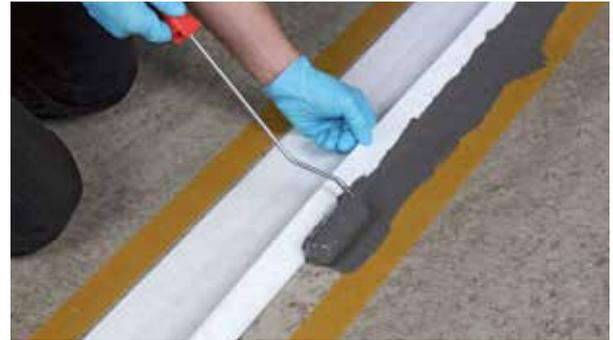
5. Nicht klebende Vlies-Streifen anheben und die verarbeitungsfertige Profi-Dicht Mischung mit einer Fellrolle satt auf den Untergrund auftragen, min. 2,0 kg/m<sup>2</sup>
