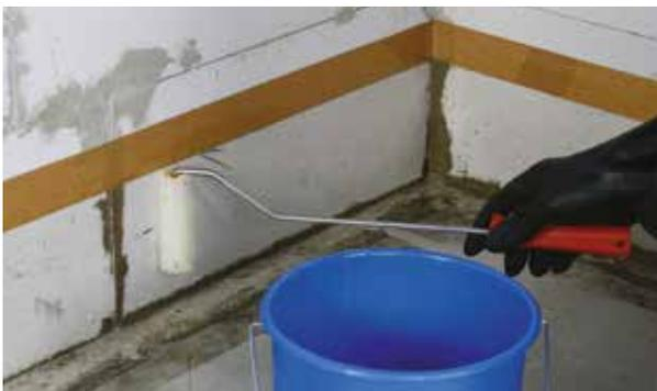
1. Die für die Abdichtung vorgesehene Fläche ggf. mit Profi-Dicht Grundierung grundieren
