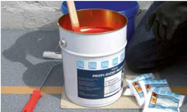
2. Profi-Dicht Markierung gut aufrühren und die benötigte Menge in ein sauberes Gefäß füllen. Nun wird die auf diese Menge und auf die Temperatur abgestimmte Menge an Katalysator zugegeben und gut untergerührt. Mischzeit mind. 2 Minuten. Anschließend ist die Profi-Dicht- Markierung-Mischung umzutopfen und nochmals umzurühren
