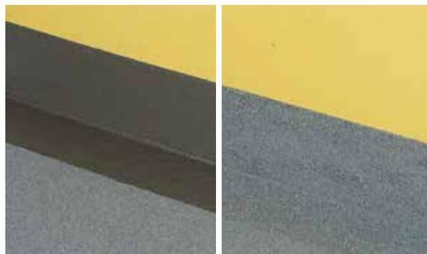
5. Abdichtenden Bereich satt mit einer Deckschicht von mind.  $1,0 \text{ kg/m}^2$  abdecken
