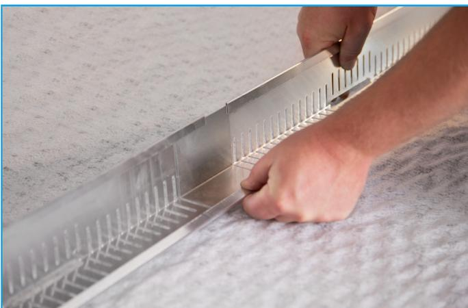
Zur Eckausbildung die Kiesfangleiste mit einer Blechschere oder einem Winkelschleifer einschneiden und in Position biegen.
