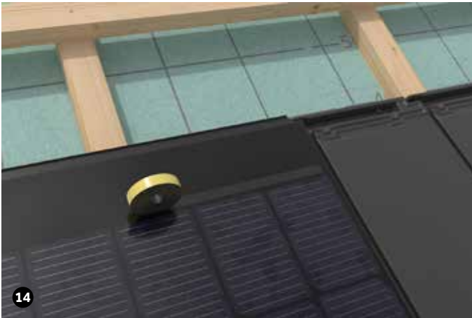
Firstseitiger Anschluss: An der Auflagestelle der Dachziegel auf das darunterliegende Modul den beiliegenden Schaumstoffstreifen entsprechend der Höhenüberdeckung der Dachziegel aufkleben.
