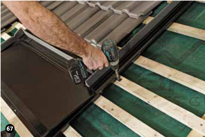
Befestigung von Seitenteil und Unterteil mit Haften.
