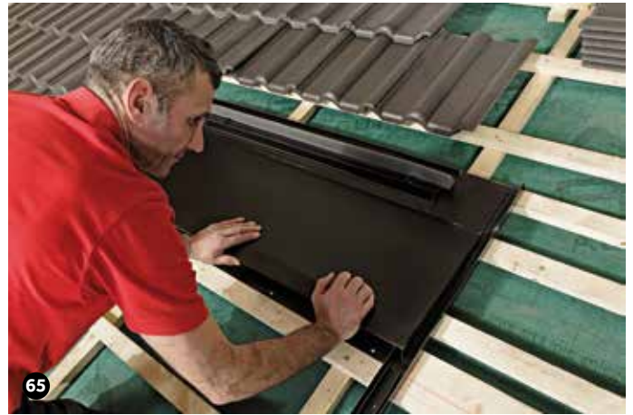
Das komplette Unterteil N in die entsprechende Position bringen. Der Einbau erfolgt analog zu den oberen Eindeckblechen lt. den Abbildungen zuvor.
