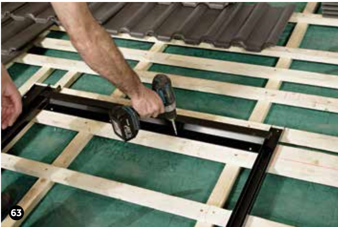
Beschreibung anhand der Spezial-Ecke A. Die Verlegung der Spezial-Ecke B erfolgt sinngemäß. Über dem obersten Modul eine Firstbefestigung mit Modulschrauben (siehe Tabelle Bemessungslasten und Befestigungsvarianten Seite 3) befestigen.
