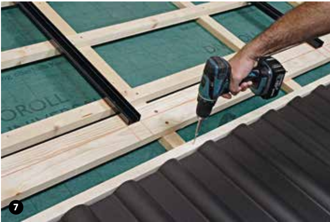
7 Als Startpunkt und spätere Auflage für die unteren Eindeckbleche eine Hilfsbohle hochkant oberhalb der Dachpfannen verlegen. Höhe: Traglattenhöhe + 2 cm
