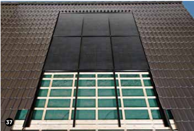
37 Vor der Montage der untersten Modulzeile werden die unteren Eindeckbleche verlegt.
