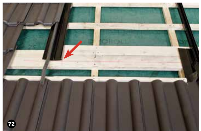
Das seitliche Eindeckblech links unten ebenfalls an der horizontalen Abschnürung auf der Hilfsbohle ausrichten.
