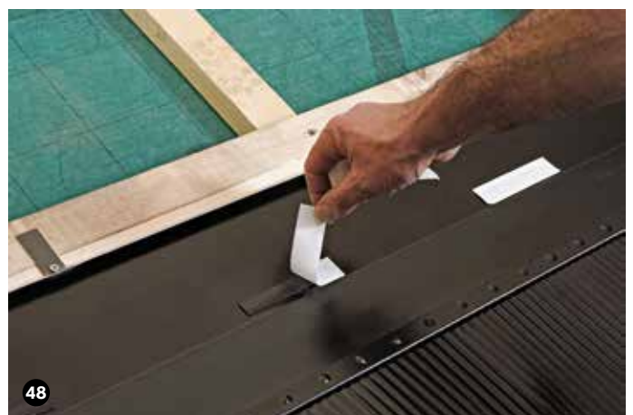
Die Klebestreifen von den Butylkleber-Pads entfernen
