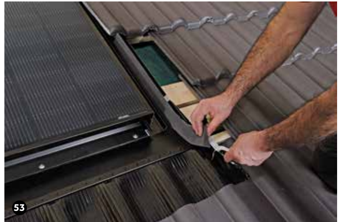
Die Schutzfolie von den seitlichen Schaumstreifen abziehen und den Schaumstreifen auf der Schürze festkleben.
