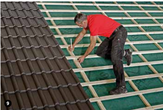
9 Positionen für die weiteren Hilfsbohlen und Hilfslatten anzeichnen. Abstand Hilfsbohlen untereinander: 1.740 mm
