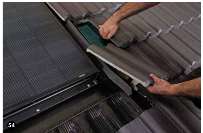
Abschließend die untersten seitlichen Dachpfannen eindecken.
