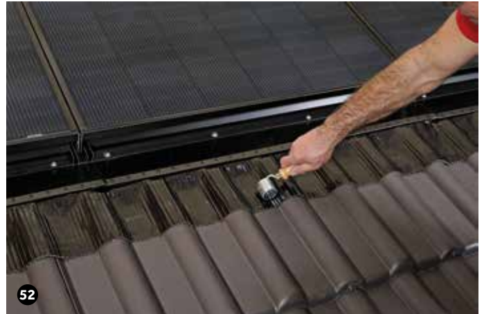
Die plissierte Schürze an die Kontur der Dachpfannen anrollen.
