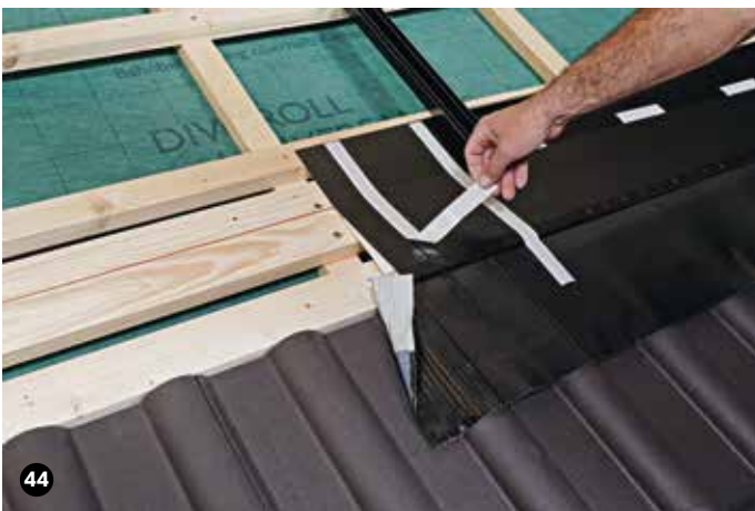
Schutzstreifen vom Butylkleber entfernen. Die Schürze, wie dargestellt, umschlagen.
