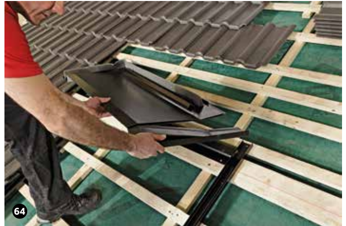
Die beiden Teile des Unterteils N zusammenstecken.
