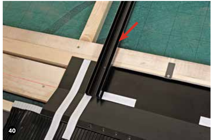
40 Die Umkantung des unteren Eindeckbleches beginnt unmittelbar neben der Drainage-Schiene.
