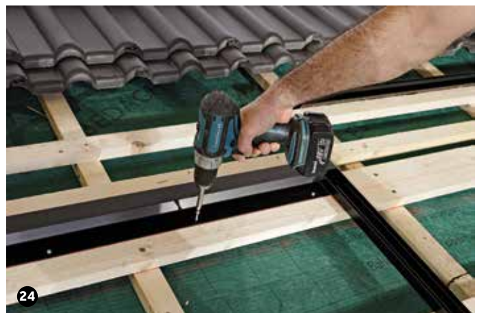
Die Unterkante der Firstbefestigung an der obersten horizontalen Abschnürung ausrichten und mit Modulschrauben (siehe Tabelle Bemessungslasten und Befestigungsvarianten Seite 3) befestigen.
