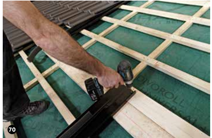
Beschreibung anhand der Spezial-Ecke D. Die Verlegung der Spezial-Ecke C erfolgt sinngemäß. Das Seitenteil U entsprechend Abschnitt 7.7.1 befestigen.
