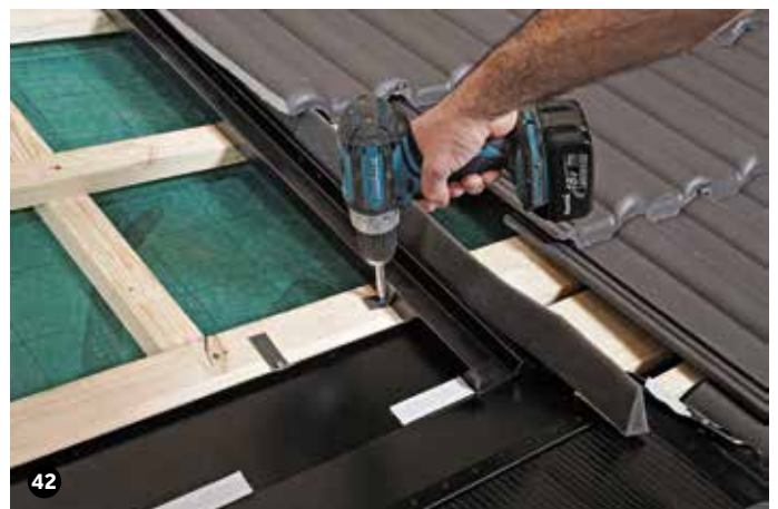
42 Unteres und seitliches Eindeckblech mit Haften befestigen.
