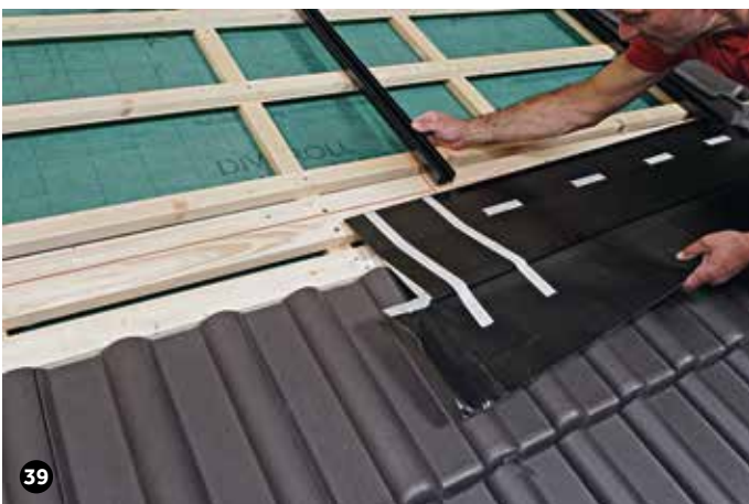
39 Rechts beginnend, das untere Eindeckblech unter das seitliche Eindeckblech und die Drainage-Schiene schieben.
