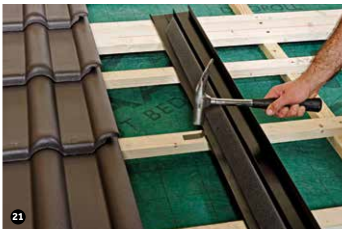
Das Eindeckblech seitlich mit Haften befestigen.
