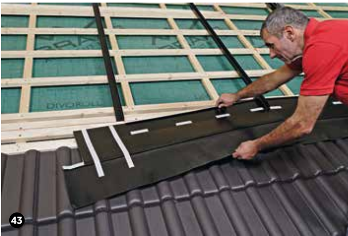
Das nächste Eindeckblech verlegen.
