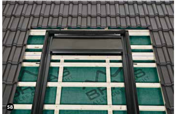
Fertig eingebauter firstseitiger Anschluss
