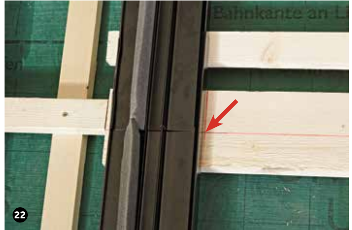
Die nächsten Eindeckbleche von oben einschieben und an der horizontalen Abschnürung ausrichten. Sichern Sie alle Bleche mit ausreichend Haften.
