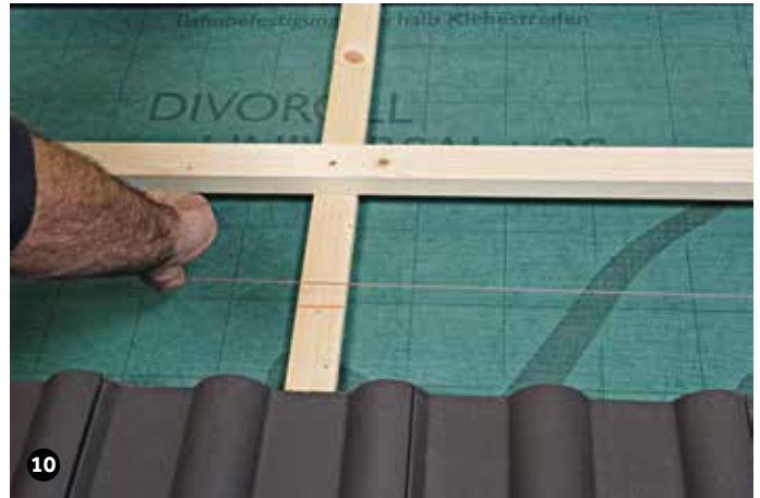
10 Positionen der Hilfsbohlen und Hilfslatten auf der Konterlatte abschnüren
