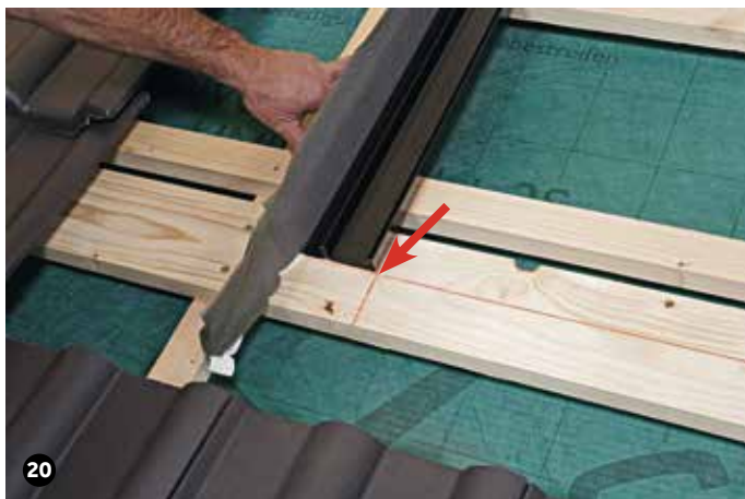
Die seitlichen Eindeckbleche von unten nach oben verlegen. Unterkante eines Eindeckbleches an der horizontalen Abschnürung und die Innenkanten an der vertikalen Abschnürung ausrichten.
