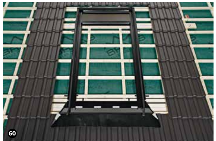
Fertig eingebauter traufseitiger Anschluss. Einbau erfolgt analog zu den unteren Eindeckblechen lt. den Abbildungen zuvor.
