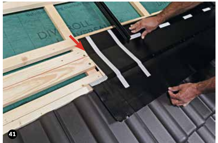
41 Der Knick des unteren Eindeckbleches liegt auf der Abschnürung auf der Hilfsbohle.
