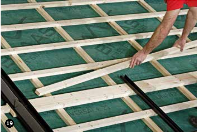
Für die Befestigung der Drainage-Schienen und seitlichen Eindeckblechen bei Bedarf eine Hilfsplatte verlegen. UK Hilfsbohle – UK Hilfsplatte: 195 mm
