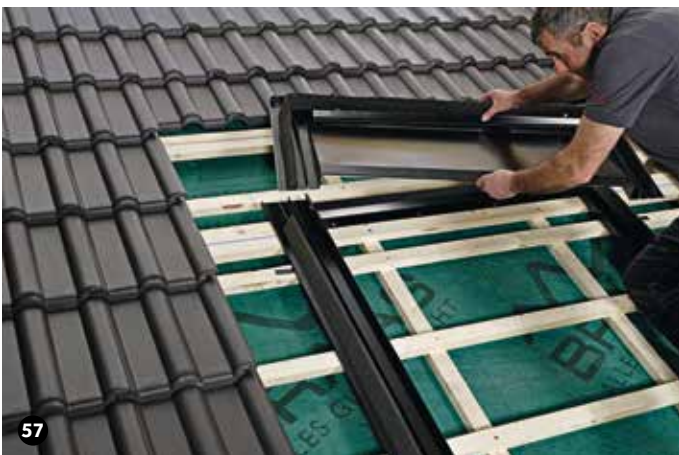
Nach dem Einbau der seitlichen Abdeckbleche und der Firstbefestigung das obere Eindeckblech einspaltig einsetzen. Der Einbau erfolgt analog zu den oberen Eindeckblechen lt. den Abbildungen zuvor.
