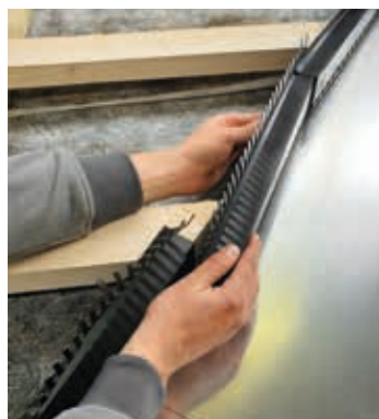
6 Det næstnederste element afkortes, så det kan samles over lægte med det nederste element.
