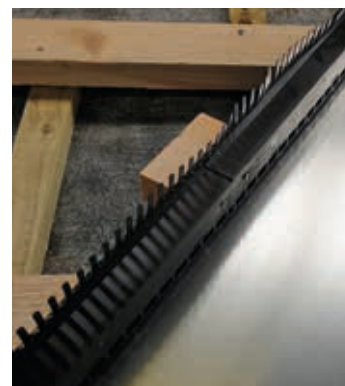
8 Ved større lægteafstande kan man med fordel montere en laske af et stykke taglægte i samlingen mellem to elementer, og begge elementer skrues fast i denne.
