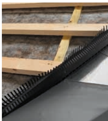
5 Det nederste element tilpasses i længden, så det passer til fuglegitter ved tagfoden. Hvis muligt afkortes elementet, så der kan laves en samling over næstsidste lægterække. Ved knæk i tagfoden skal det sidste element smigskæres i enden.
