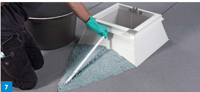
7 Richtlatte entfernen und mit Villaperl auffüllen
