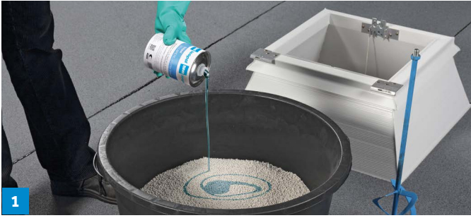
1 Villaperl-Schüttung zusammen mit dem Villaperl-Härter in einen runden 90 l Behälter füllen
