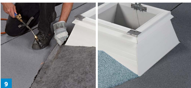
9 Villaperl ist nach ca. 1 Std. begehbar – nachfolgende Schichten müssen nach Aushärtung des Materials direkt aufgebracht werden
