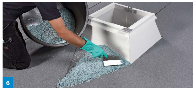
6 Villaperl auf der markierten Fläche verteilen
