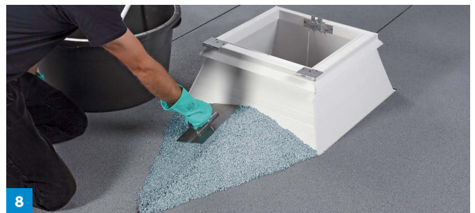
8 Villaperl andrücken und glätten
