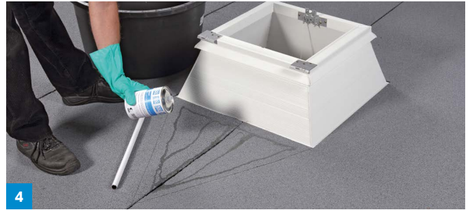
4 Ggf. Villaperl-Härter als Haftverbesserer auf dem Untergrund verteilen
