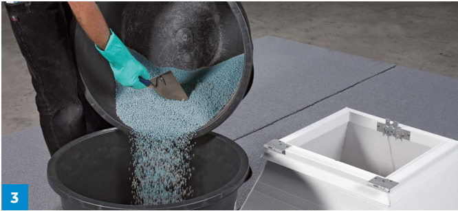
3 Wichtig: Anschließend umtopfen und nochmals mind. 1 Minute mischen, damit die Schüttung gleichmäßig mit dem Härter benetzt wird
