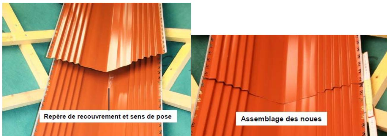
Figure 5 – Pose de la seconde longueur
