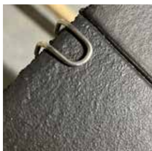
Bilder 1: U-Clip montert i sidefals øverst på steinen
