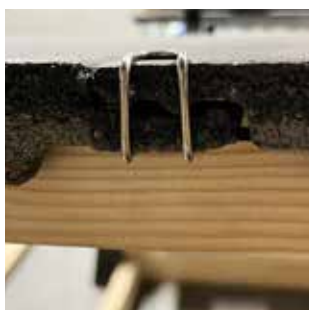
Bilder 1: U-Clip montert i sidefals øverst på steinen
