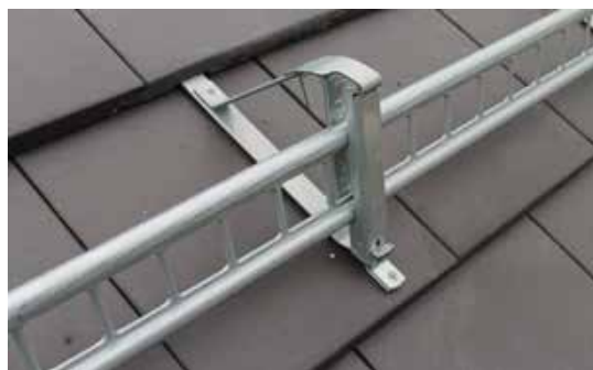
Bilde 2: Montering av snøfanger
