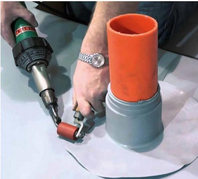
Suelde la base del paso de tubería alrededor de su circunferencia hasta la lámina monocapa de cubierta colocada por debajo. Comprueba la calidad de la soldadura en la unión y repare cualquier zona sospechosa.
