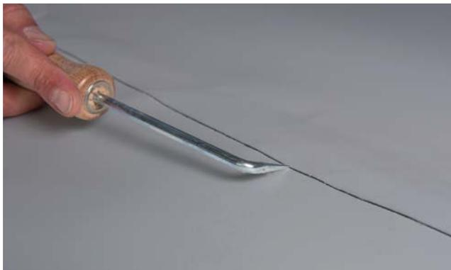
Figura 15. Comprobación de la unión con una sonda.
