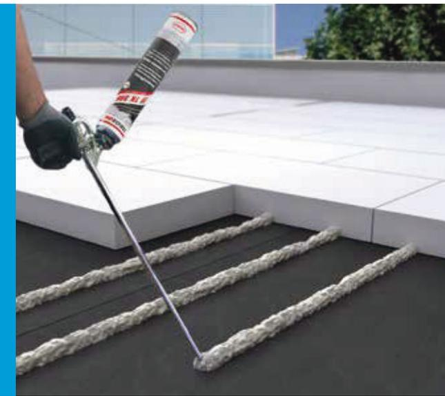
Teroson EF TK 395 ist speziell für die Verklebung von Dämmstoffen im Flachdachbereich entwickelt worden.
