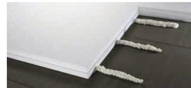
Klebstoff als Raupe auftragen, Dämmstoff einlegen, festdrücken – fertig.
