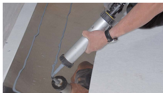
Zur Verklebung der Verbundblechprofile wird rückseitig Wolfinator Montageklebstoff aufgebracht.
