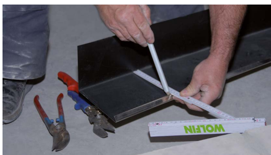
Sorgfalt beginnt bei der Vorbereitung: Zuschnitt und Montage der Wolfen Edelstahl-Verbundblechelemente.
