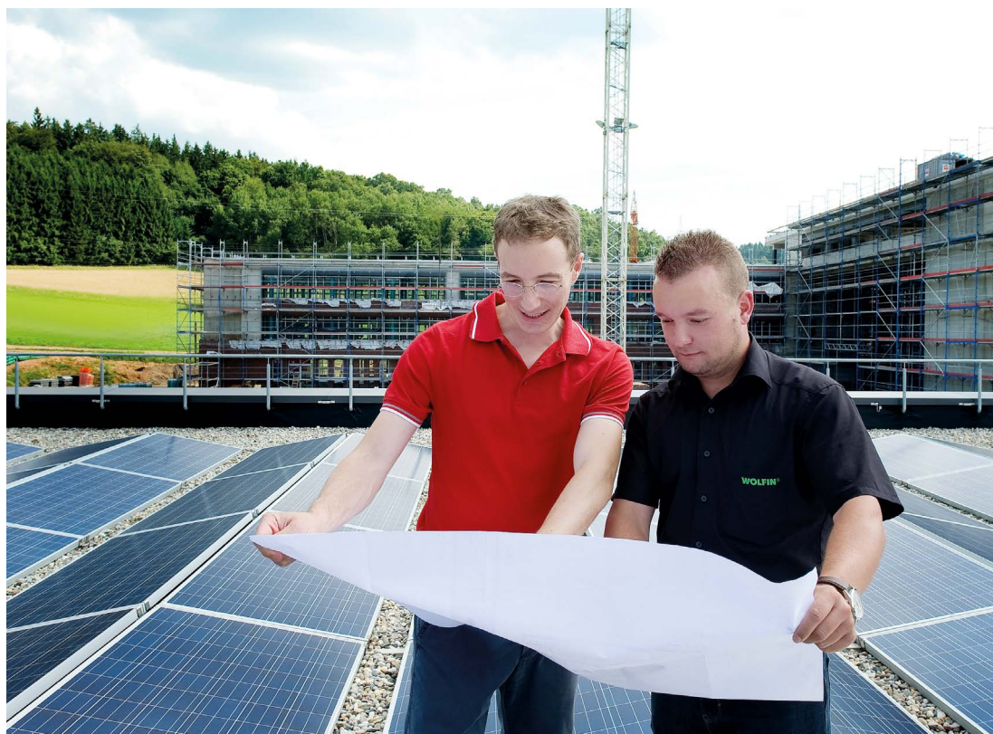
Steffen Strauss mit dem BMI Anwendungstechniker Daniel Wiegand auf der Großbaustelle im hessischen Biebergemünd.
