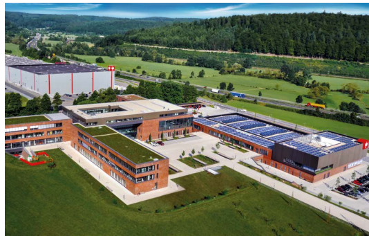
Gut 30.000 Quadratmeter Dachfläche – abgedichtet mit Produkten der Marke WOLFİN.
