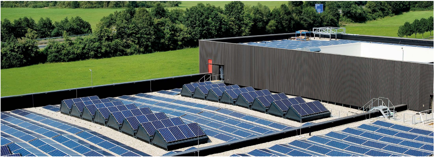
Wolfin M lose unter Auflast verlegt mitaufgeständerter Photovoltaik.
