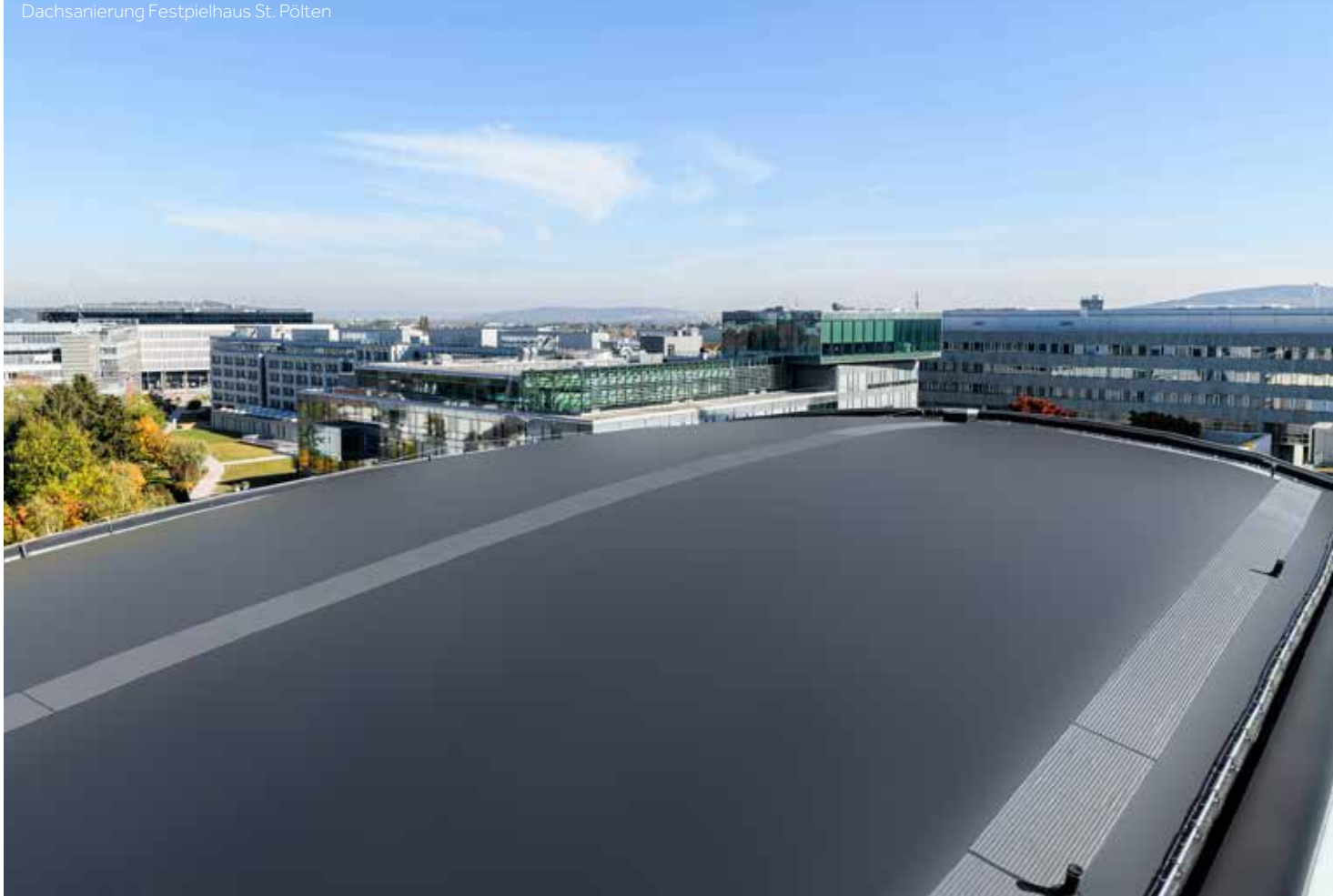
Dachsanierung Festspielhaus St. Pölten
