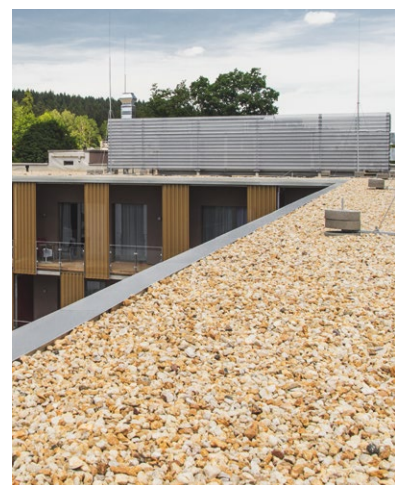
Verlegung unter Auflast
