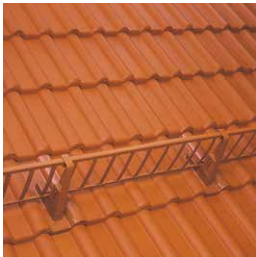
Sicher ist sicher: die Schneefang sicherung
