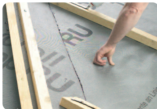
Csonka ellenlécek beépítése
