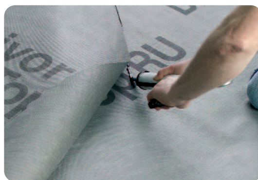
Bramac Fóliaragasztó felhordása
