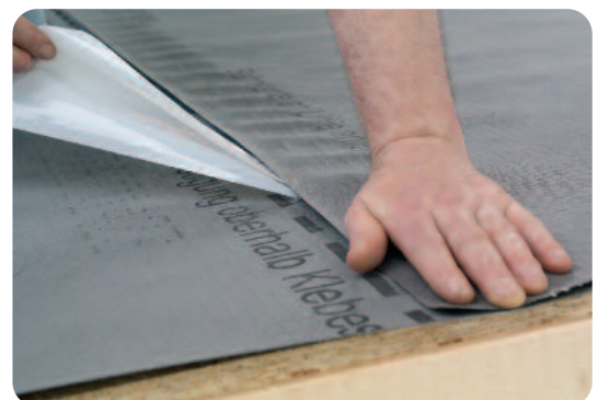
A ragasztósáv rányomása kézzel vagy hengerrel
