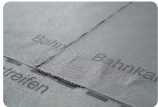
Elkészült toldás
