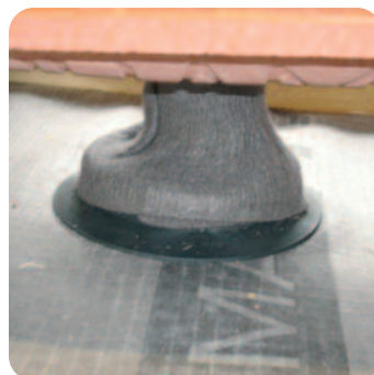
FlexiRoll az antennatartó csőre csatlakoztatva
