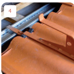
4 A biztonsági tetőhorgot a hullámvölgy közepébe pozícionáljuk, majd a csavarozással rögzítjük.
