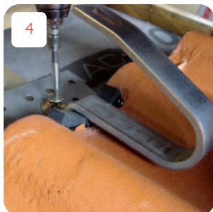
4 A tetőhorgokat a mellékelt csavarokkal az ellenléceken át a szarufához rögzítjük.
