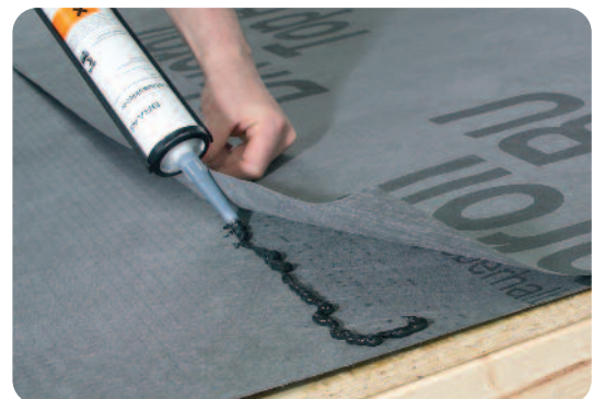
Lezárás Bramac Fóliaragasztóval
