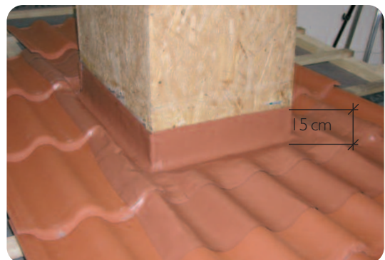
Wakaflex kémény- és falszegély felvezetése a kémény oldalára
