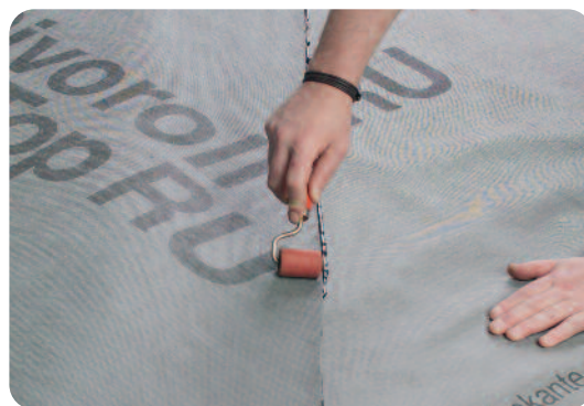
Ragasztás préselése henger segítségével
