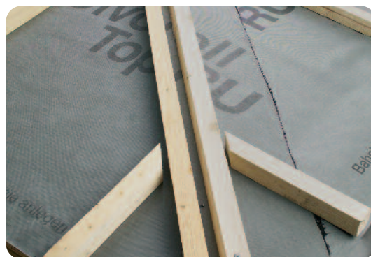
Beépített, rögzített ellenlécek
