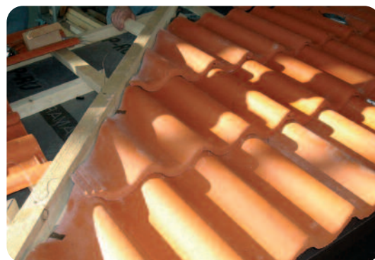
Tetőcserepek illesztése a gerinlécéhez
