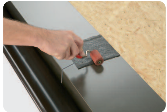
Cseppentőlemez toldásának átlapolása Wakaflex kémény- és falszegély elemmel.
