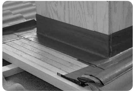
Kiépített deszkázat a kémény gerinc feletti oldalán
