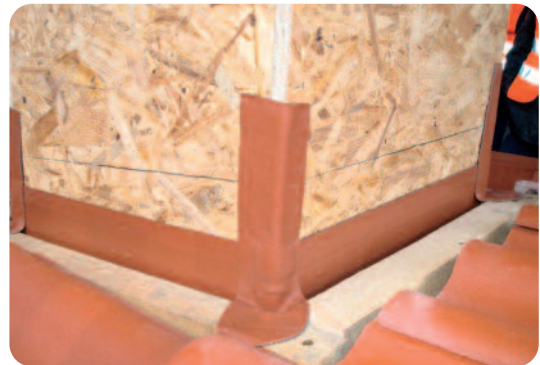
Kéménysarkok kialakítása Wakaflex kémény- és falszegély sávmegegerősítéssel
