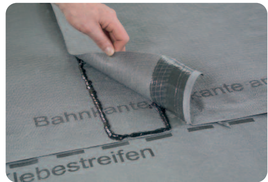
Bramac fóliaragasztó felhordása
