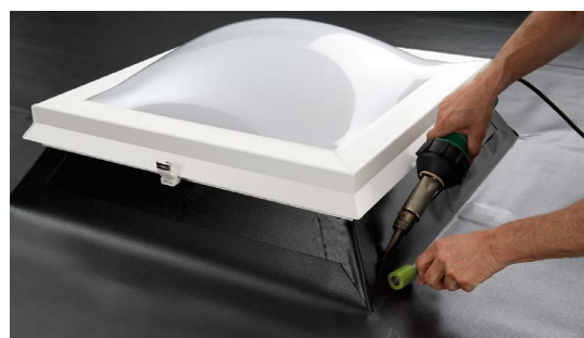
Wolfin Verbundbleche als Lichtkuppelanschluss
