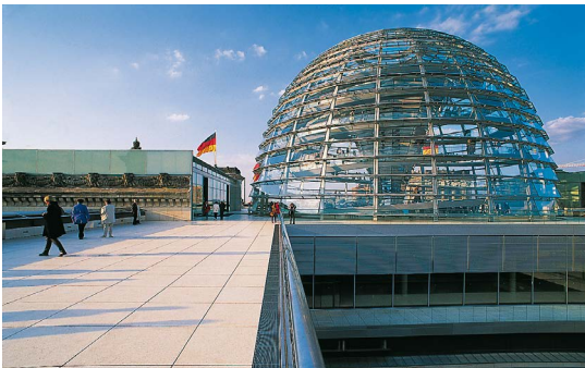
Sicher abgedichtet mit dem Wolfin PYE-System: Das Dach des Reichstags in Berlin.
