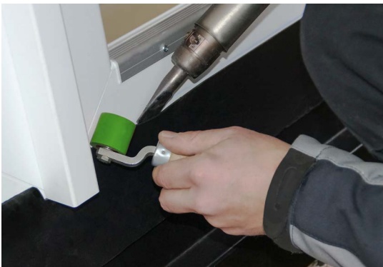
Wasserdichter und sicherer Anschluss an PVC-Tür- und Fensterelemente mittels Heißluft.
