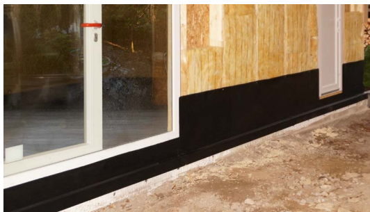
Rissüberbrückende Abdichtung für Bodenplatte und Sockelbereich
