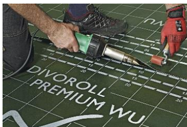
Esecuzione di raccordi con aria calda.
