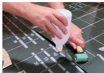
Esecuzione di raccordi con solvente.
