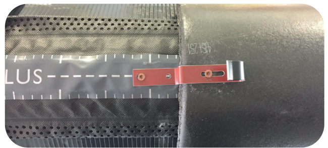
Figaroll Plus -tuulettuva harja-/ulkotaitetiiviste sekä harjatiilen kiinnikkeen asennus.
