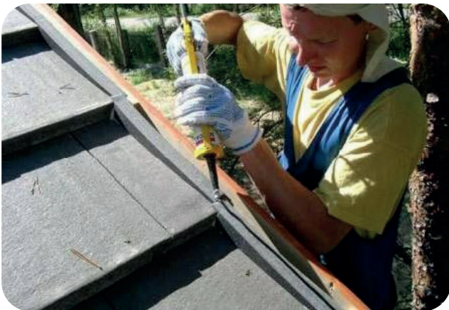
Päätyräystäspellin tiivistepalojen asentaminen.
