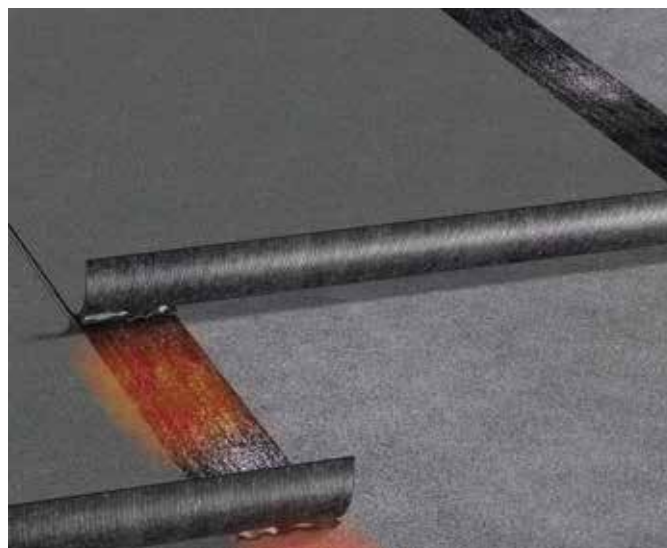
Omtekking på gammelt asfalt takbelegg.
