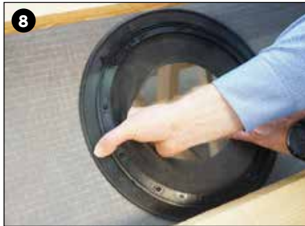
Luk den øverste ring (flip-ring) ved af folde den ned mod undertaget.
