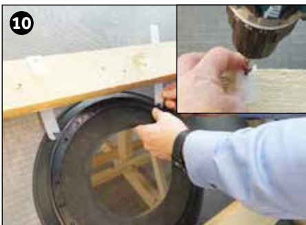
Monter stropper i montagehanke og fastgør til lægte.
