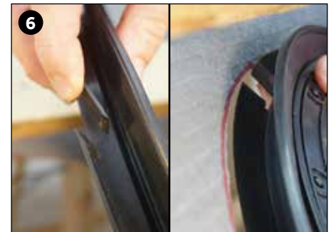
Monter gennemføringen i undertaget, ved dertil indrettet spor.
