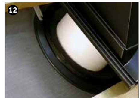
Isæt aftrækshætte med rund isørør og fortsæt montering af tagdækningen. Hætten fastgøres med sidefalsbinder eller tagsten rundt om hætten fastgøres.
