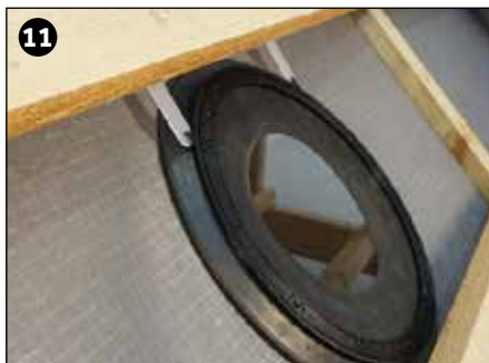
Gennemføring færdig monteret.
