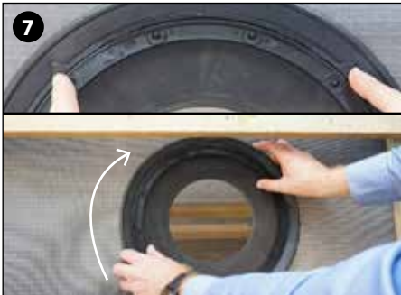
Drej gennemføringen med uret indtil de to montagehanke vender op ad mod tagryggen.
