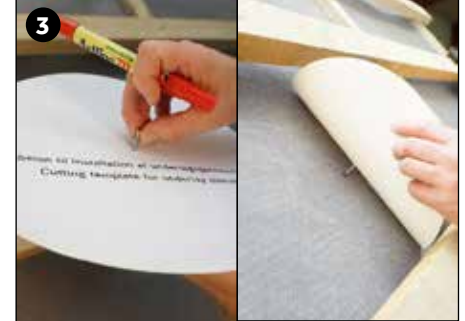
Hold center af skabelon fast med skrue eller søm i markering i undertaget.
