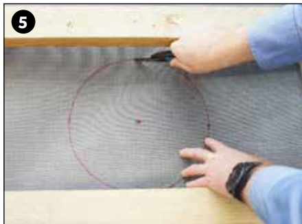
Udskær hul i undertaget langs markering. Ved Bitumen banevareundertag skæres hul radius evt. +5 mm større. Skær hul i underlag ved fast undertag.
